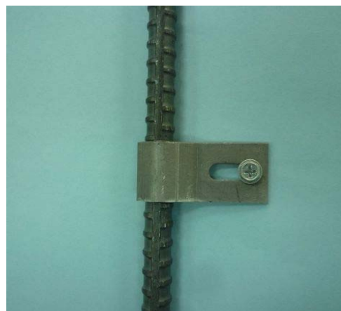
鉄筋固定（拡大）
