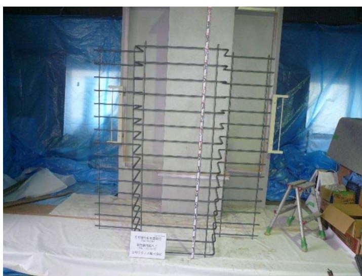
組立鉄筋搬入
