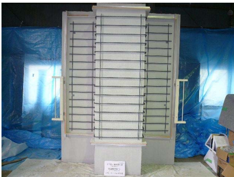
鉄筋パネル建込み完了
