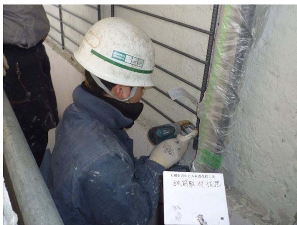
鉄筋固定作業
